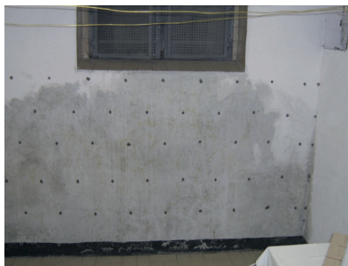
Plošná zábrana proti vztlínající vlhkosti – vrty
