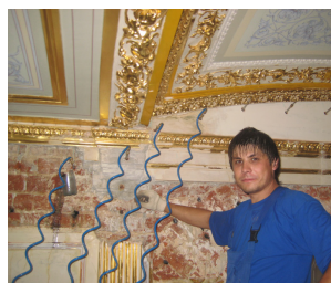
Kreml, Moskva - plošné zábrany v interiéru aplikované tlakově
