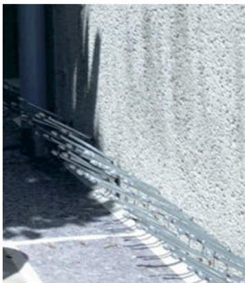
Vrty s osazenými injektážními pakry (hubicemi) pro provedení mikroemulzní zábrany.
